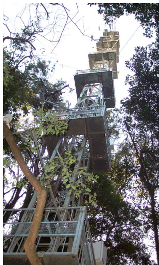
碳通量铁塔 © 鼎湖山站/CERN
